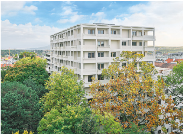
1 Theodor-Körner-Kaserne (2022) Leysersstraße 4a, 1140 Wien
